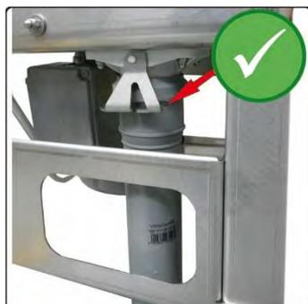
Все водяные стоки машины следует подключить с канализационной сети кухни через достаточно большие сифонные затворы.
